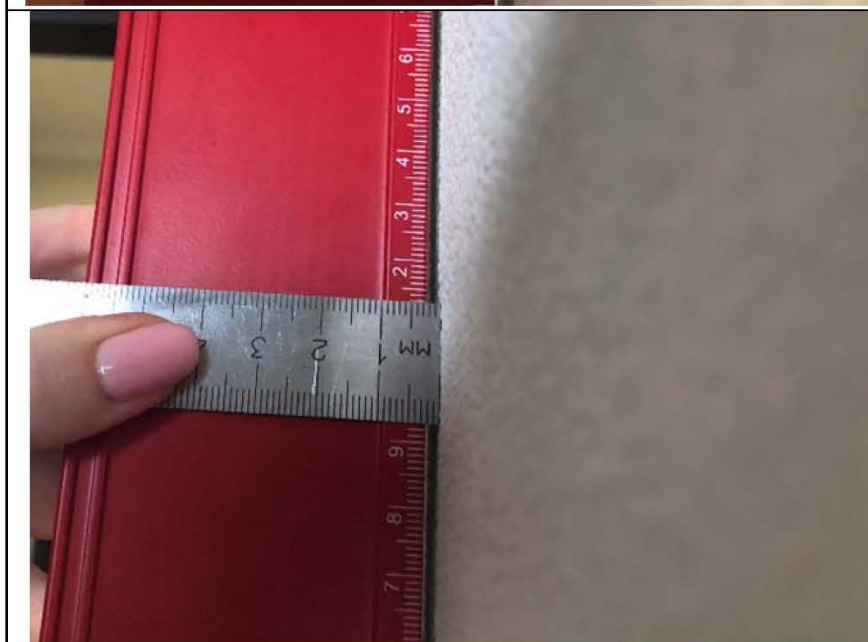
Фото №8. Измерение уровня стен кухни в квартире.
