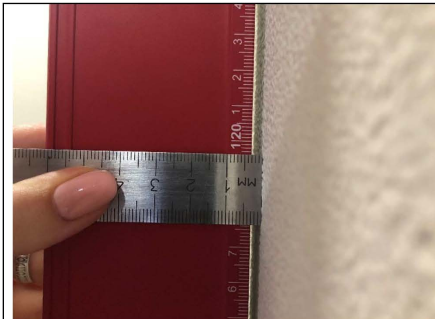
Фото №7. Измерение уровня стен коридора в квартире.
