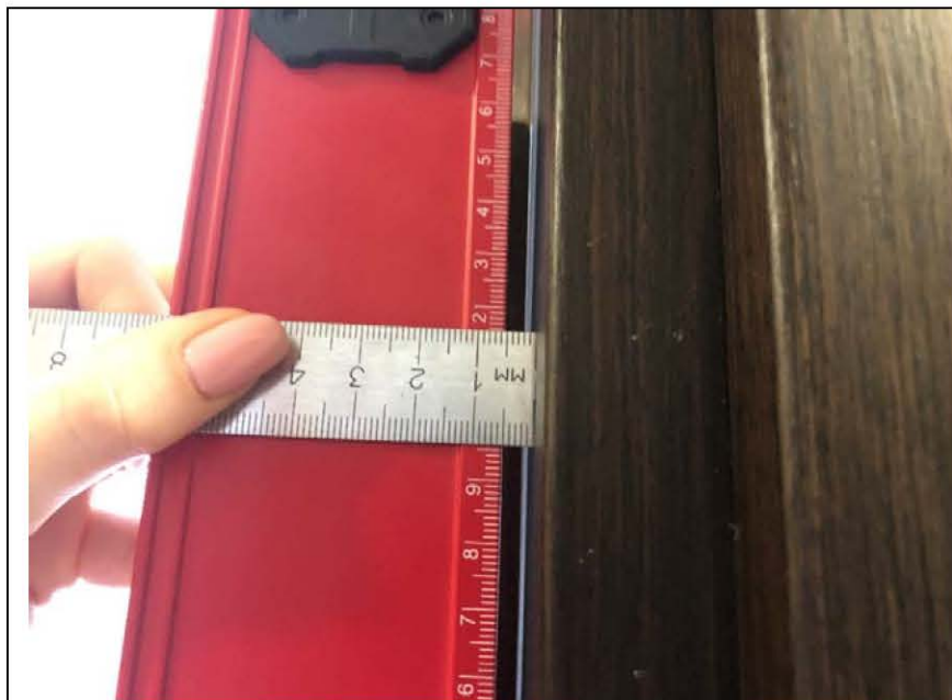
Фото №13. Измерение дверного блока в спальне в квартире.
