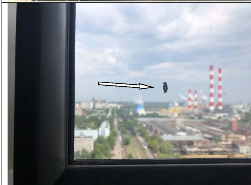
Фото №21. Загрязнения на стеклопакете оконного блока ПВХ в лоджии.
