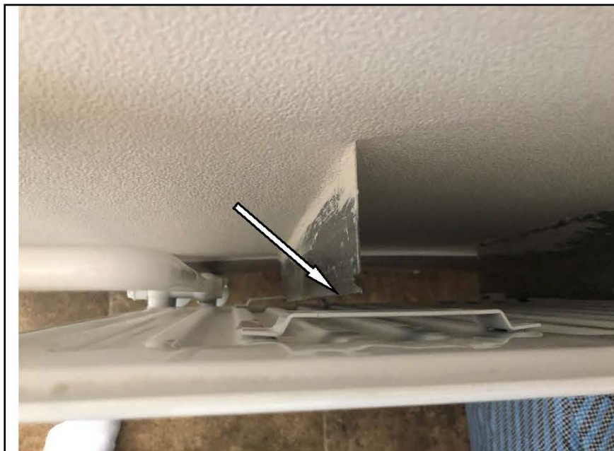
Фото №19. Отопительный прибор в кухне смонтирован неровно.
