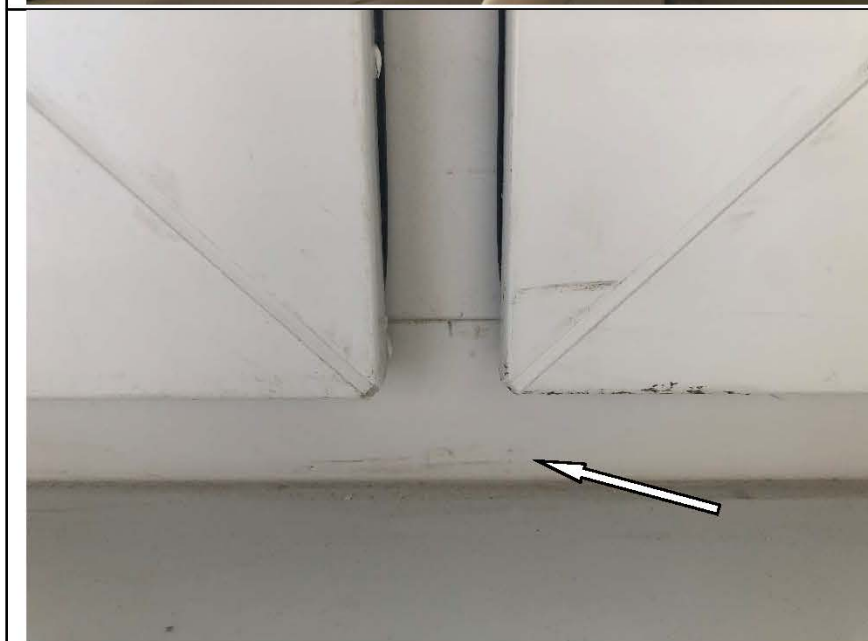
Фото №18. Профиль ПВХ оконного блока в спальне имеет дефекты (загрязнения).
