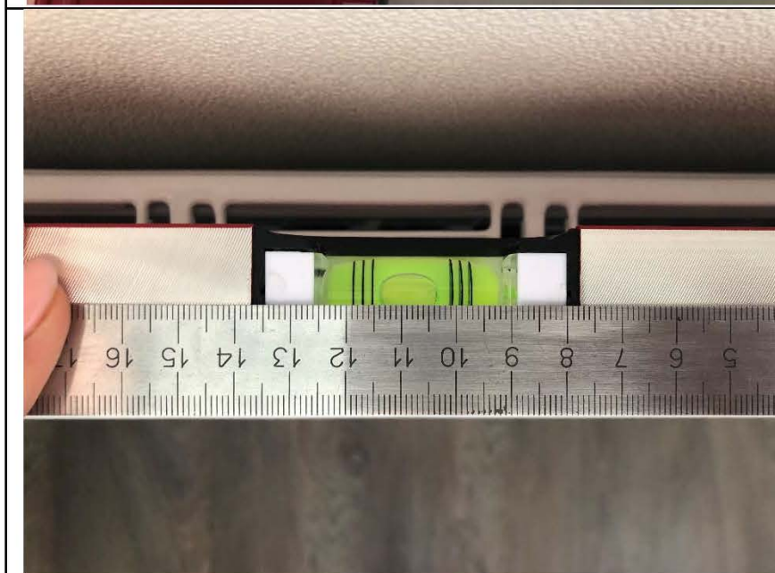
Фото №9. Отопительный прибор в спальне смонтирован неровно.
