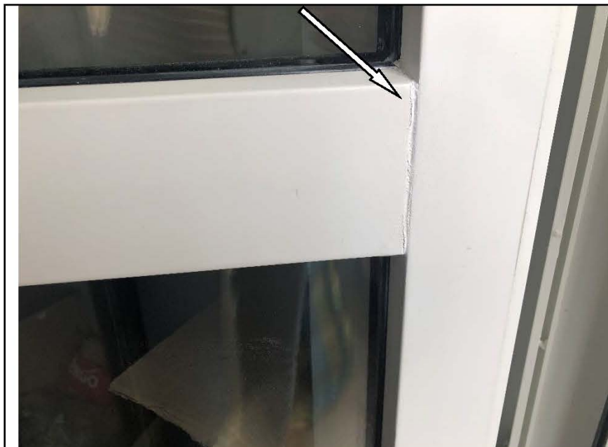
Фото №16. Профиль ПВХ дверного блока лоджии загрязнен.
